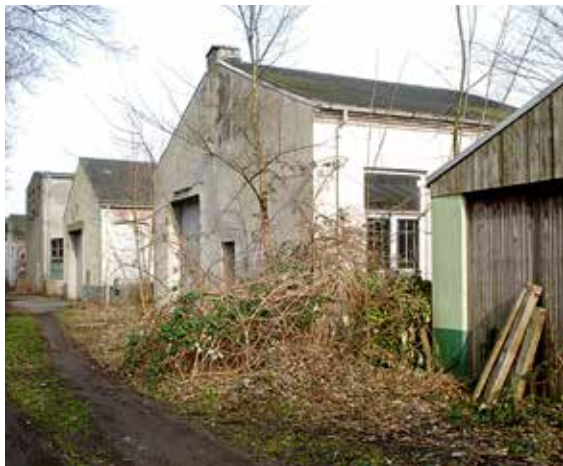
Abbruch von Teilbereichen des Werksgeländes
